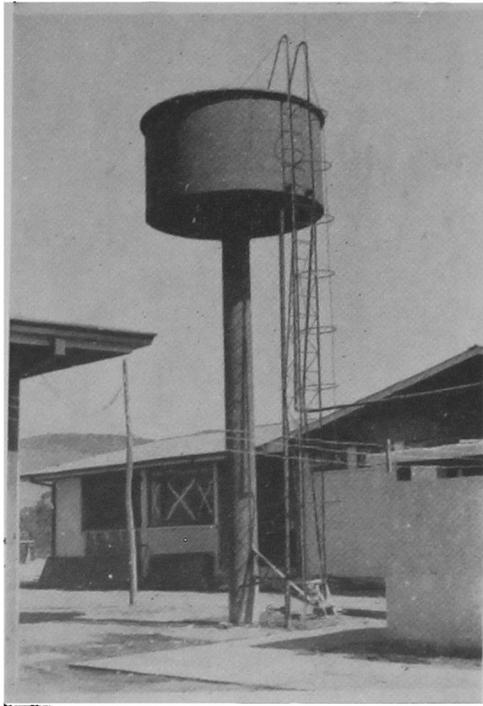
**Figura 13.** Estanque elevado de acero, intacto - Hospital nuevo de La Ligua
