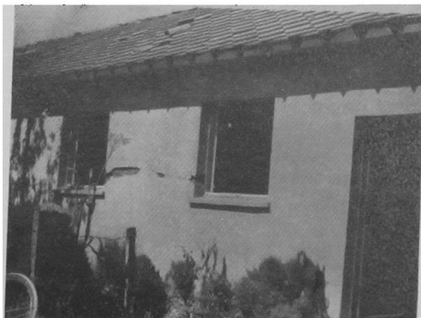
**Figura 36.** Albañilerías de ladrillo sin cadenas ni pilares, Panquehue
