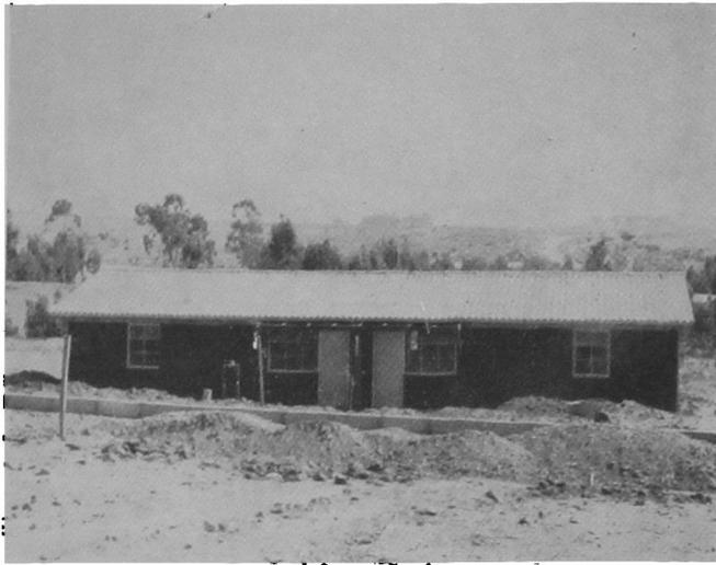
**Figura 28.** Albañilerías de ladrillos con cadenas de hormigón armado y sin pilares, intactas, La Ligua
