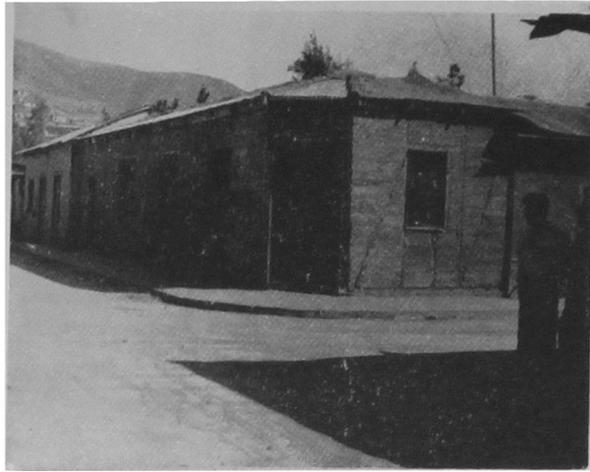
Figura 31. Tabiquerías de madera con relleno de hormigón, intactas, La Ligua
