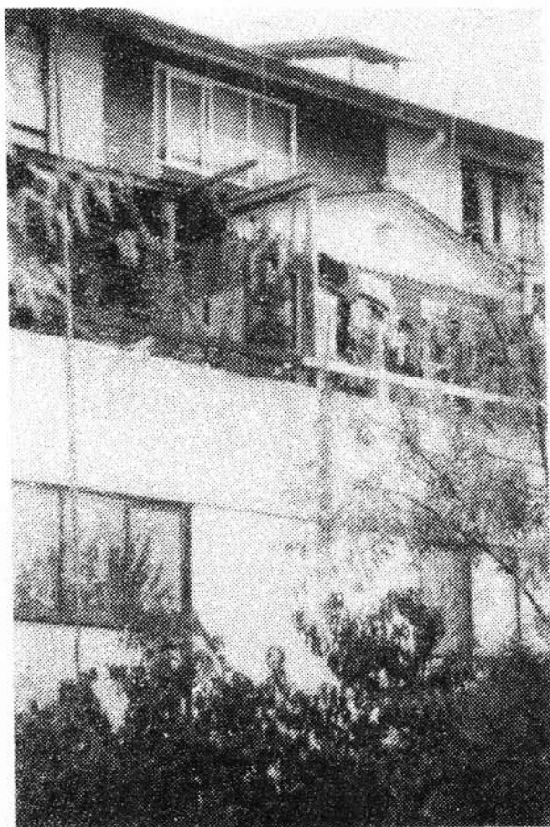
Extensión de un departamento en la terraza de un bloque de 4 pisos en dúplex. costo conveniente.
