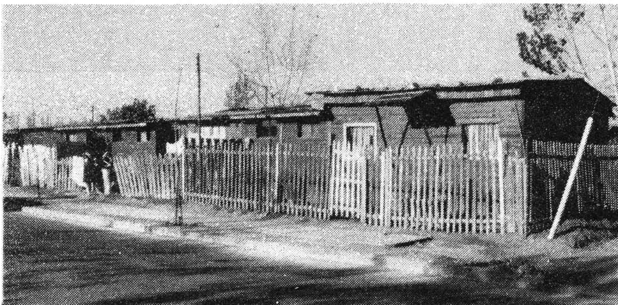
Imagen caótica por la no conformación del frente hacia la calle en una operación con Servicio Sanitario en el antejardín.
