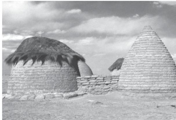
Imagen 9: La vivienda Chipaya presenta un sistema dimensional en el uso de los tepes o bloques de tierra para conseguir regularidad en la forma circular y su cubierta de cúpula. (Foto A. Calla)
