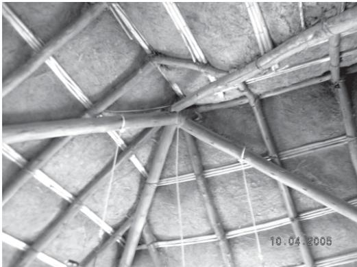
Imagen 8: La Ta'jta es una técnica tradicional de cielo raso que se debe preservar porque mejora las condiciones térmicas en el interior de la vivienda. (Foto A. Calla)
