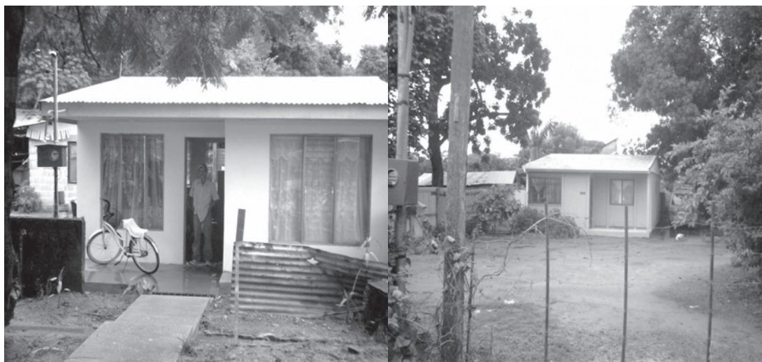
Figura 2: Ejemplos de la tipología de mejoramiento de vivienda: la vivienda de la izquierda se encuentra en la carretera a la Costa y la de la derecha en la Calle Real.
