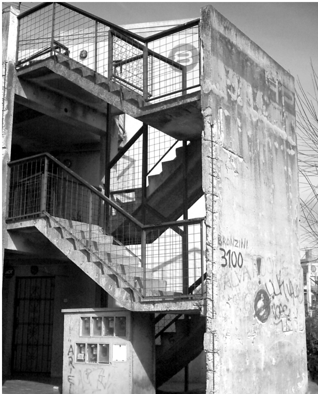
Foto 2: Detalle de acceso por escaleras del sector B
