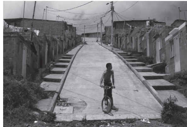
FOTO 22. Falta de conexión urbanística con el entorno. Fuente: Anne-Catherine Chardon.
