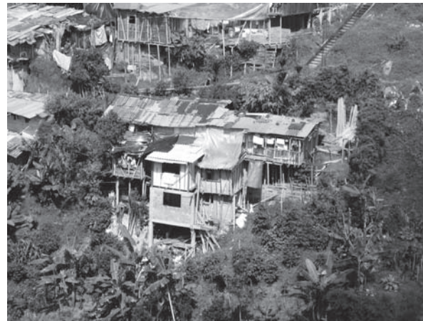
FOTO 9. Sector Bajo Andes, una vivienda tipo "Lego" con mezcla de sistemas constructivos y materiales. Fuente: Anne-Catherine Chardon. PICTURE 9. "Lego-brick" housing mixing building and material systems, Bajo Andes area. Source: Anne-Catherine Chardon
