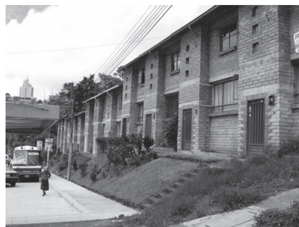
FOTO 18. Un proyecto habitablemente digno. Fuente: Anne-Catherine Chardon.
